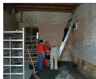
Ausbau des Projektbüros
